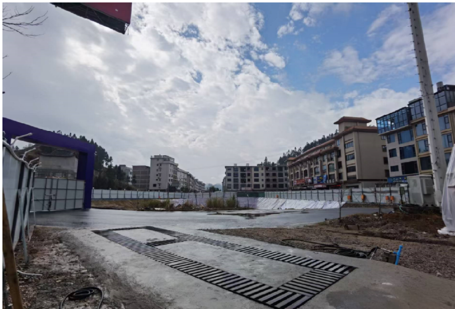
图 1.1-2 项目区现状照片 02
