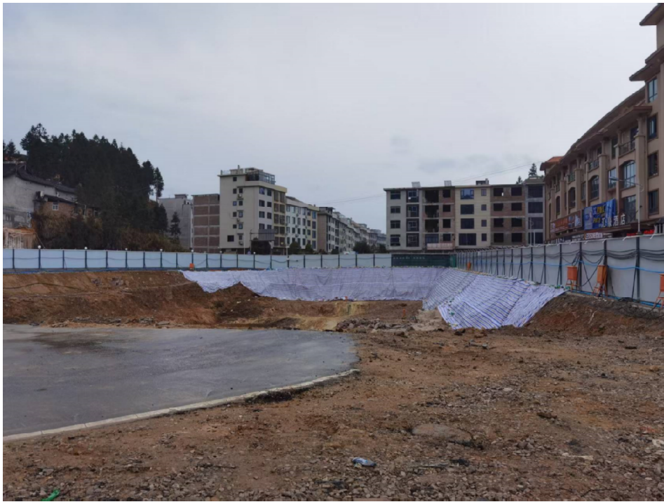
图 1.1-1 项目区现状照片 01
