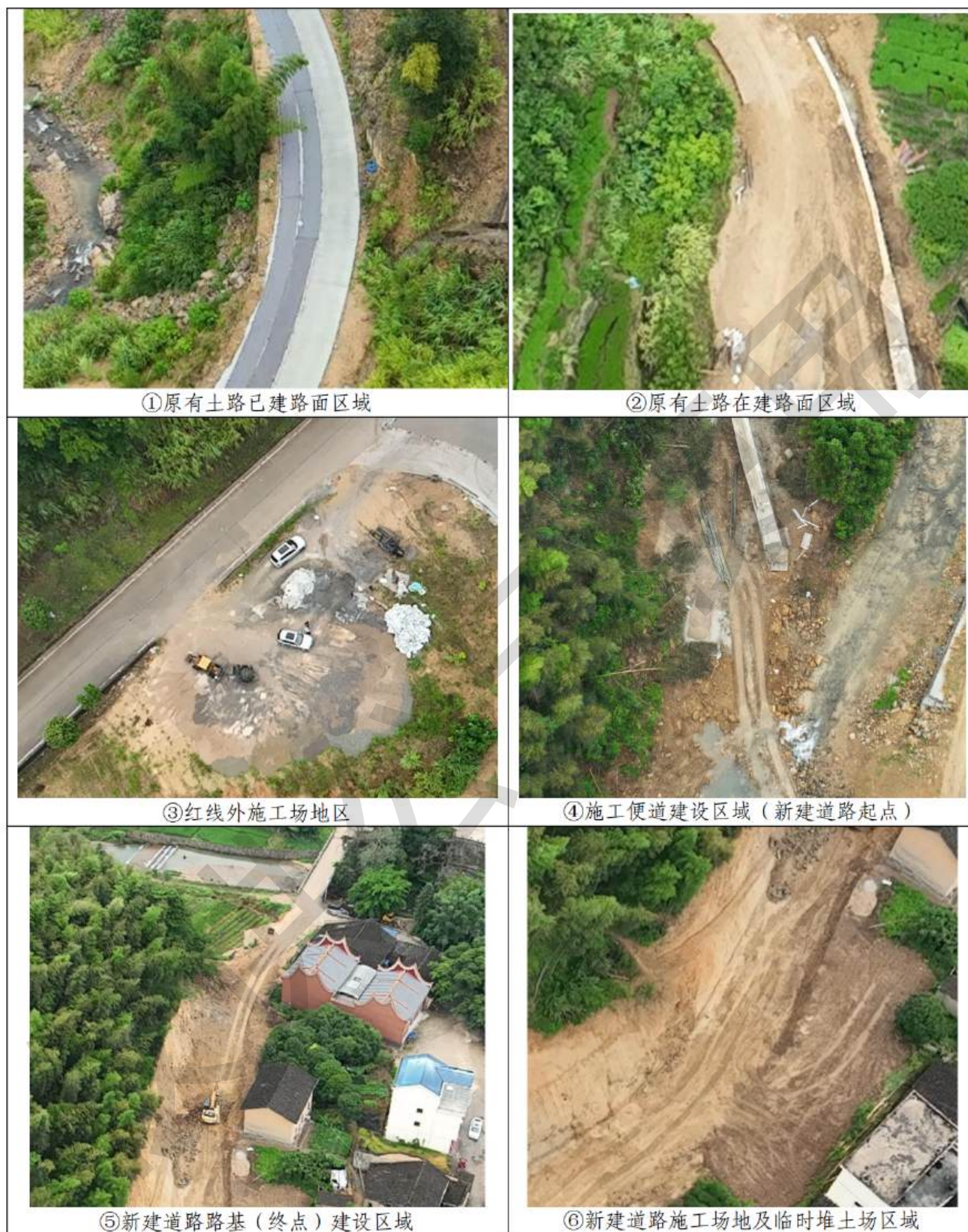
图 2.1-1 项目现场照片
