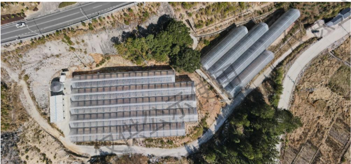
图 1-2 项目现场照片
